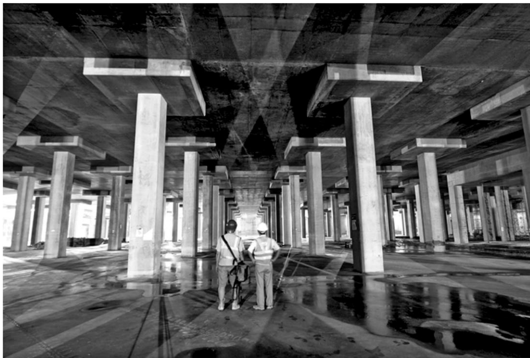
圖4 香港旺角大坑東地下蓄洪池
