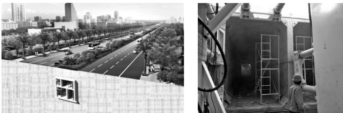
圖5 海口椰海大道綜合管廊
